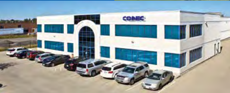
CONEC Canada, Brampton
